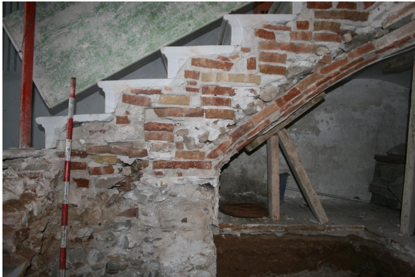
089-14-009 Vista des del NO del desmuntatge de l'escala
