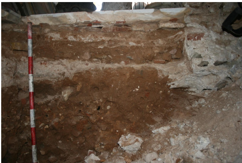
089-14-005 Vista des del N dels nivells UE 107 i 109 i la capa de morter UE 108
